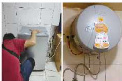
▲新冰箱安裝中
